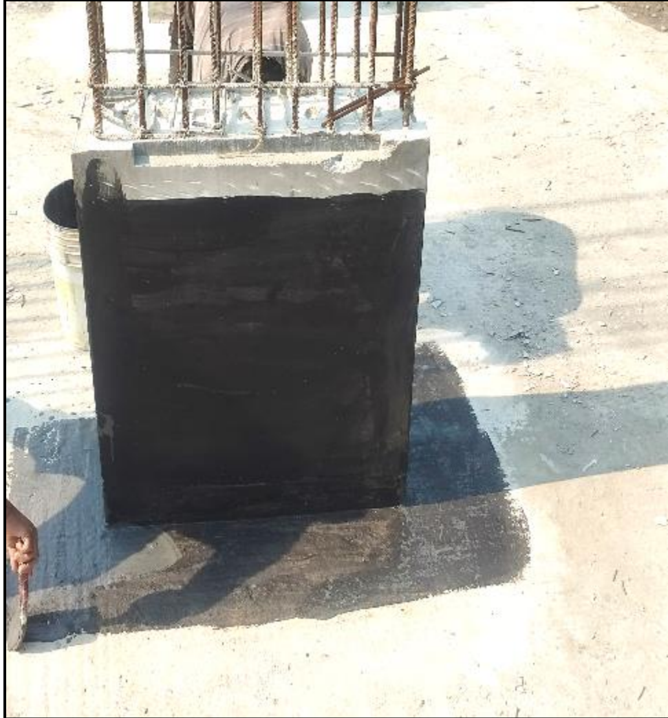
Main building – Pour 1 & 2 DPC primer Applied on column
